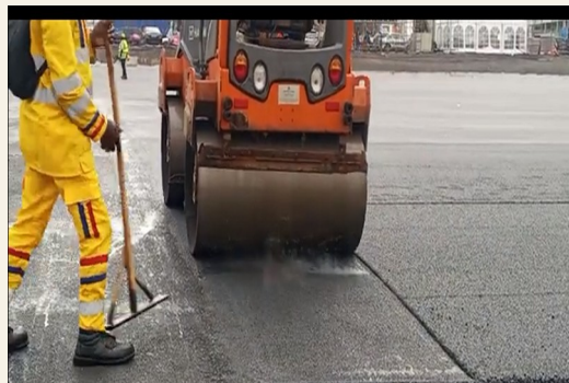
Bitumage complet de la place
