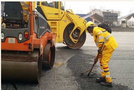
Terrassement et compactage du site
